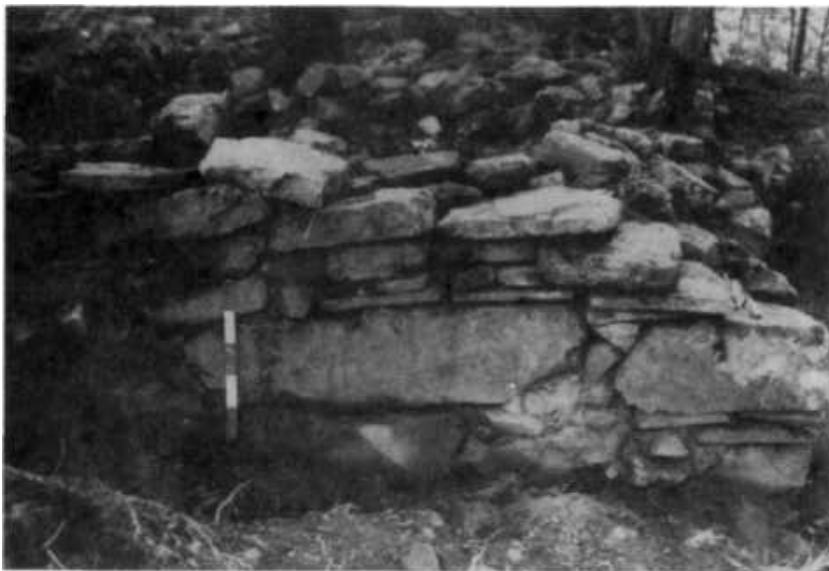
Particolare della muratura del lungo edificio rettangolare sulla sommità.
