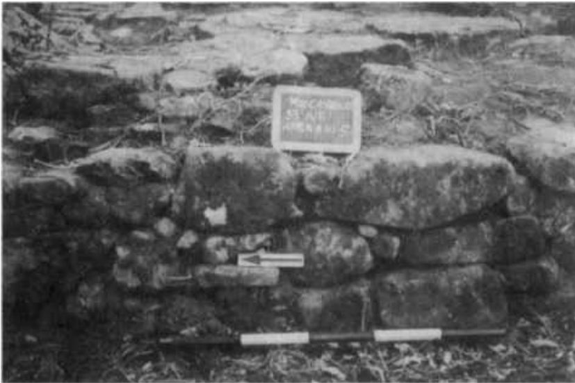
Particolare dell'Aia: muro di terrazzamento.
